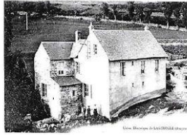
L'usine électrique de Laguiole fondée en 1903 par Henri Bélières
